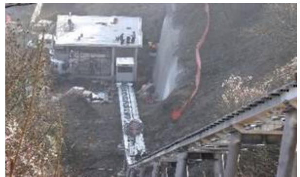
Böschungssicherung durch vernagelte Spritzbetonschale an der Talstation
