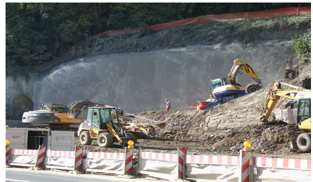
Böschungssicherung durch vernagelte Spritzbetonschale an der Talstation
