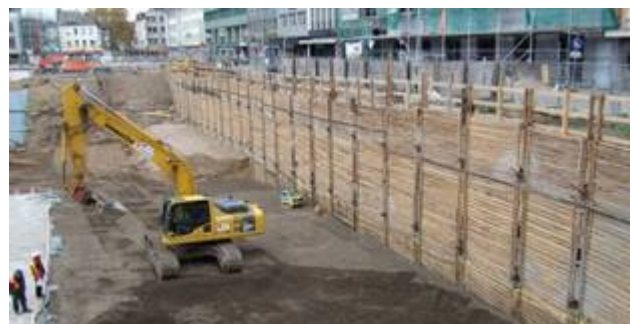
Baugrube am Zentralplatz
